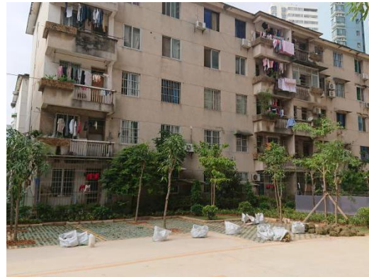
项目北面旧住宅楼
